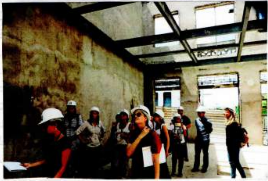
Visita guiada pelas engenharias da Secretaria de Habitação à obra dos sobrados de João Pessoa/PB
