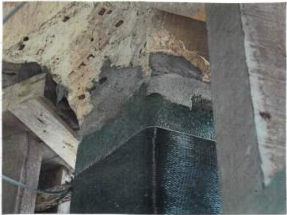
Detalhes da aplicação da fibra de carbono
