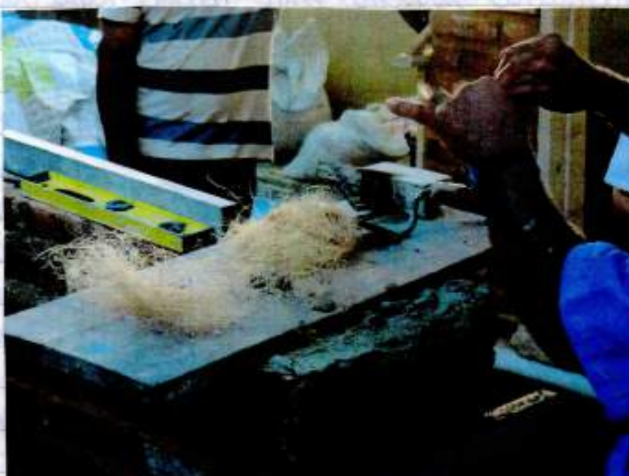
Amauri fazendo uma cornija estruturada com sisal
