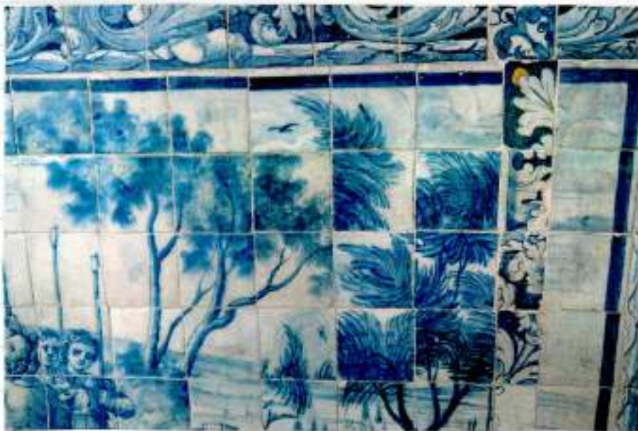
Detalhe dos azulejos re-ordenados após o restauro.
