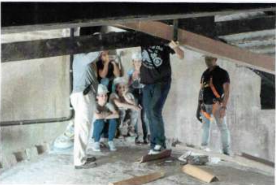
Aluno reali- zando teste de telha
